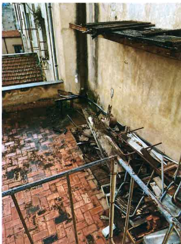
Foto 11 - Terrazzo Quarto Piano
