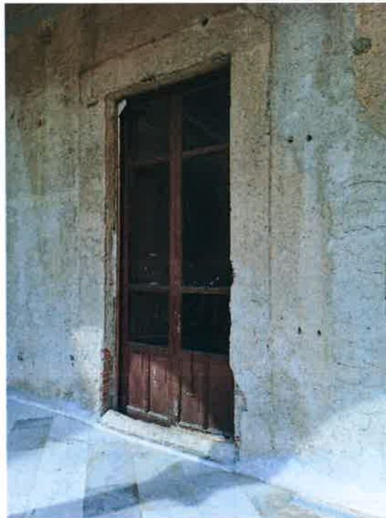
Foto 24– Infisso esterno Aula Magna
