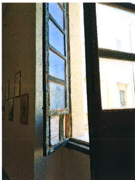
Foto 27 – Infisso Piano Primo
