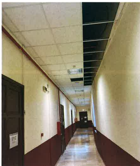
Foto 17 - Corridoio piano Terzo
