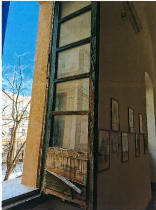
Foto 21– Infisso Piano Primo
