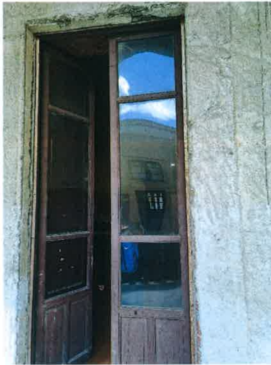
Foto 23 – Infisso esterno Aula Magna
