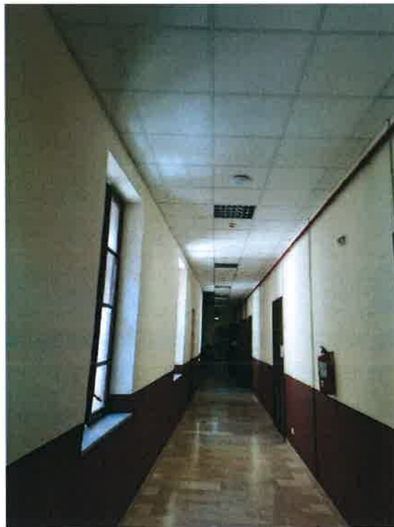
Foto 16 – Corridoio piano Terzo
