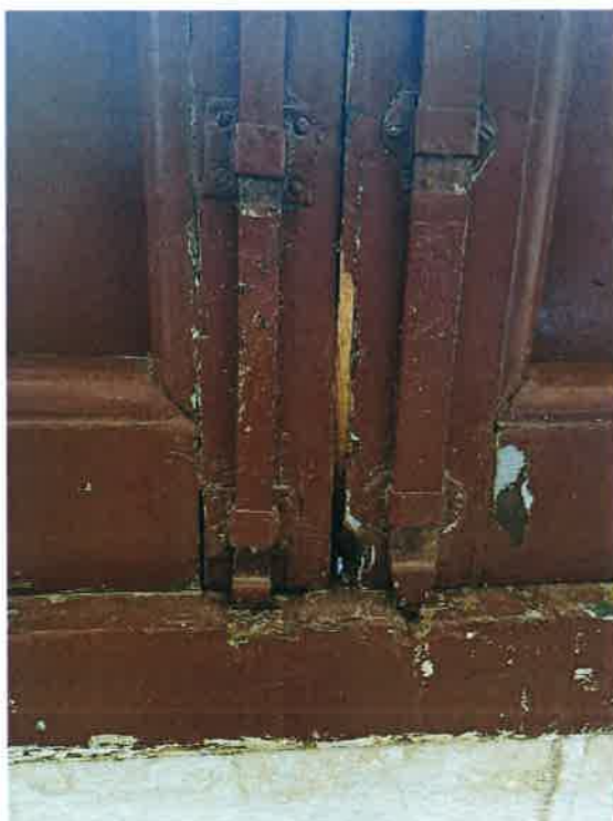
Foto 28 – Infisso Piano Primo
