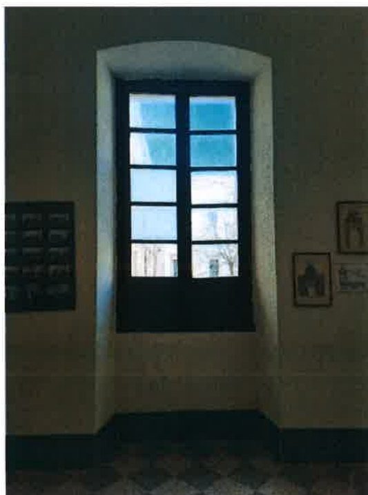
Foto 20 – Infisso Piano Primo
