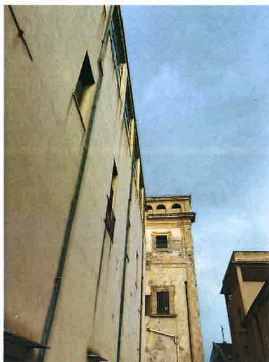
Foto 7 - Prospetto Terrazzo via Del Collegio Giusino
