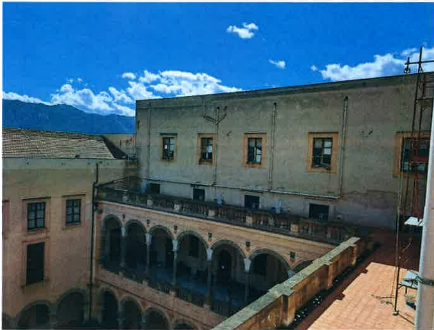
Foto 1 – Prospetto Piano Terzo
