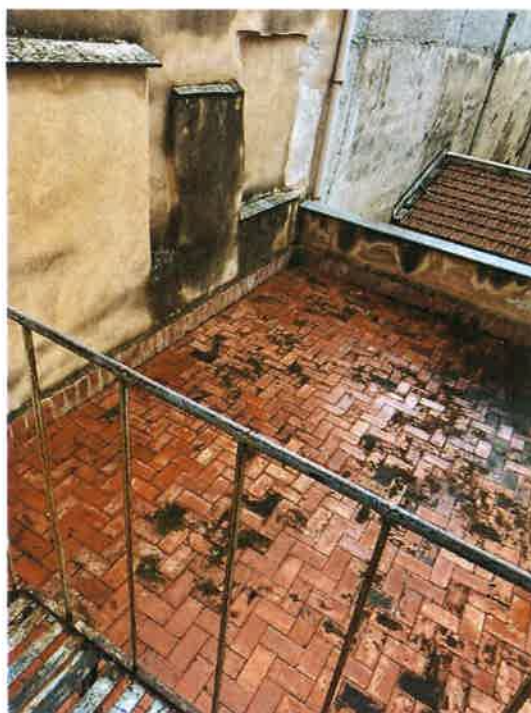
Foto 12 – Terrazzo Quarto Piano
