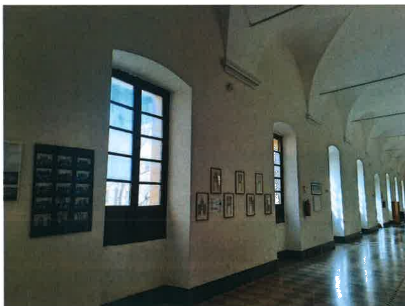
Foto 14 – Corridoio Primo Piano
