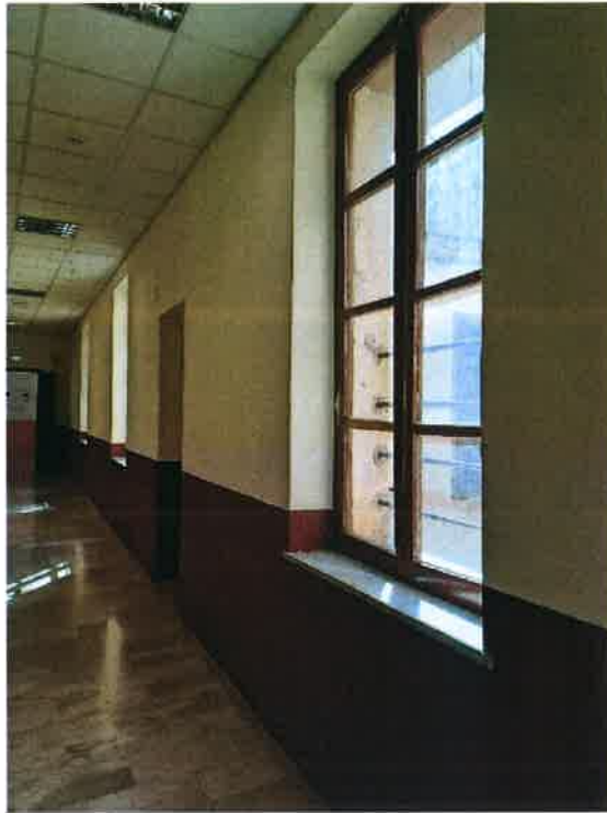
Foto 15 – Corridoio Piano Terzo
