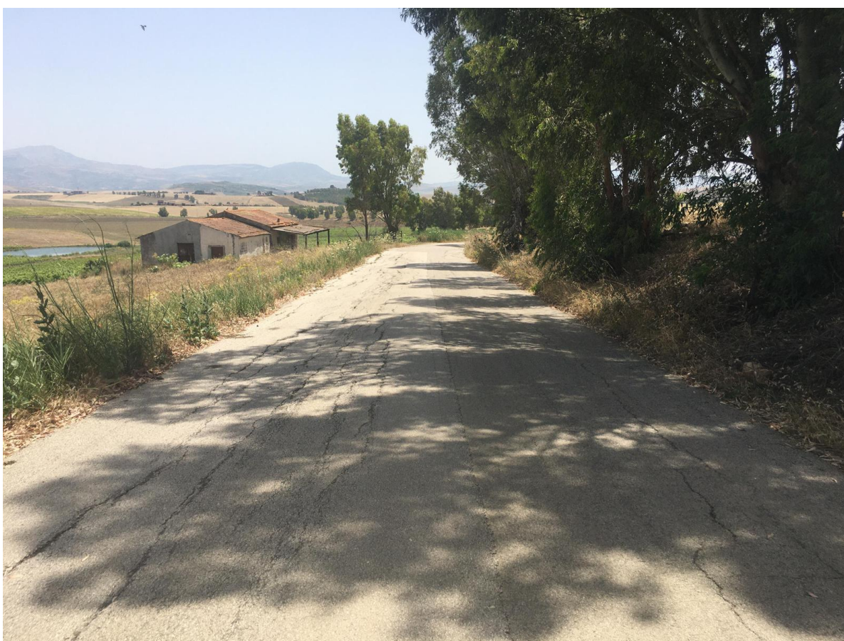
Foto 02 - Sede stradale oggetto di intervento
