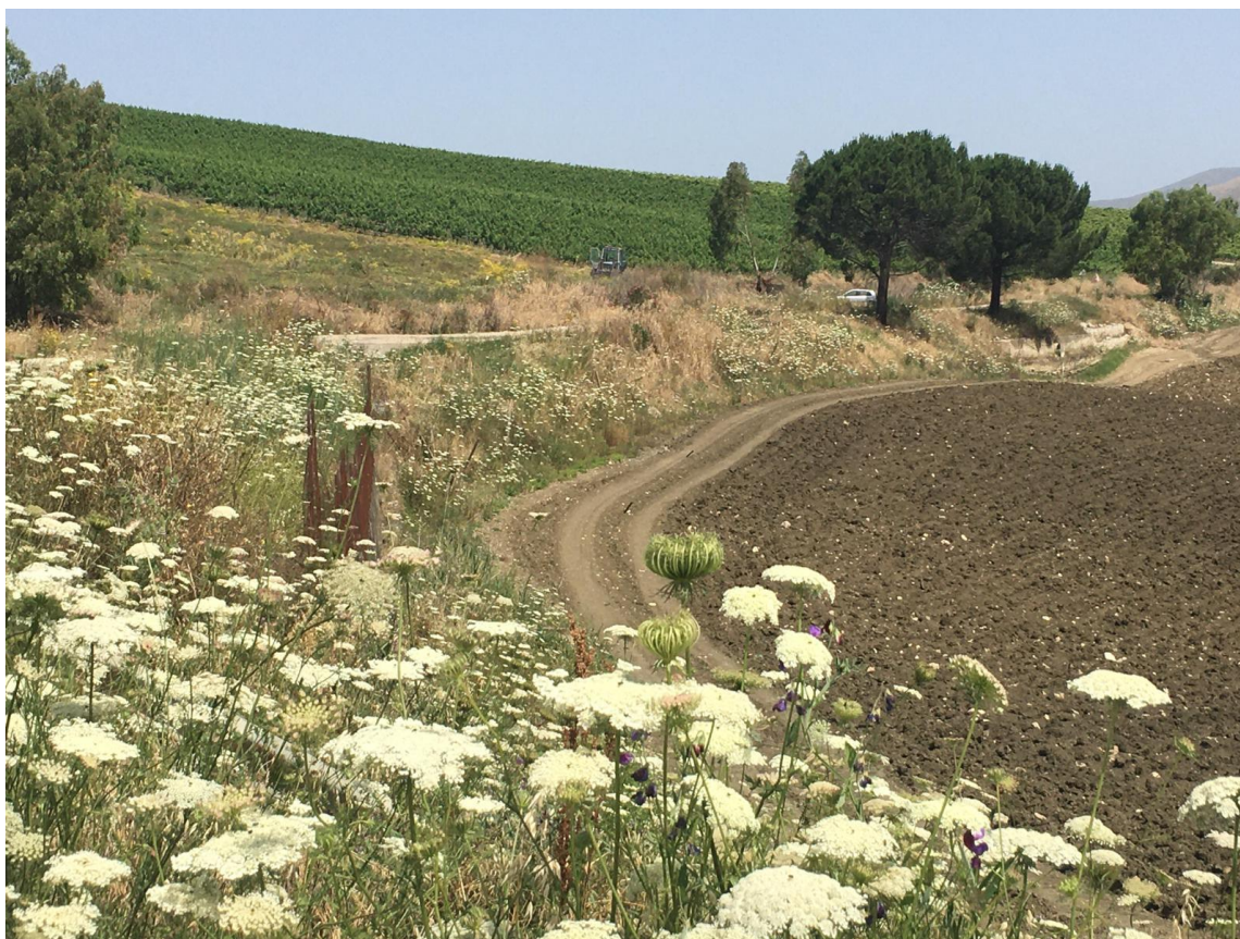
Foto 04 – Particolare: scarpata km 11+150 oggetto di intervento
