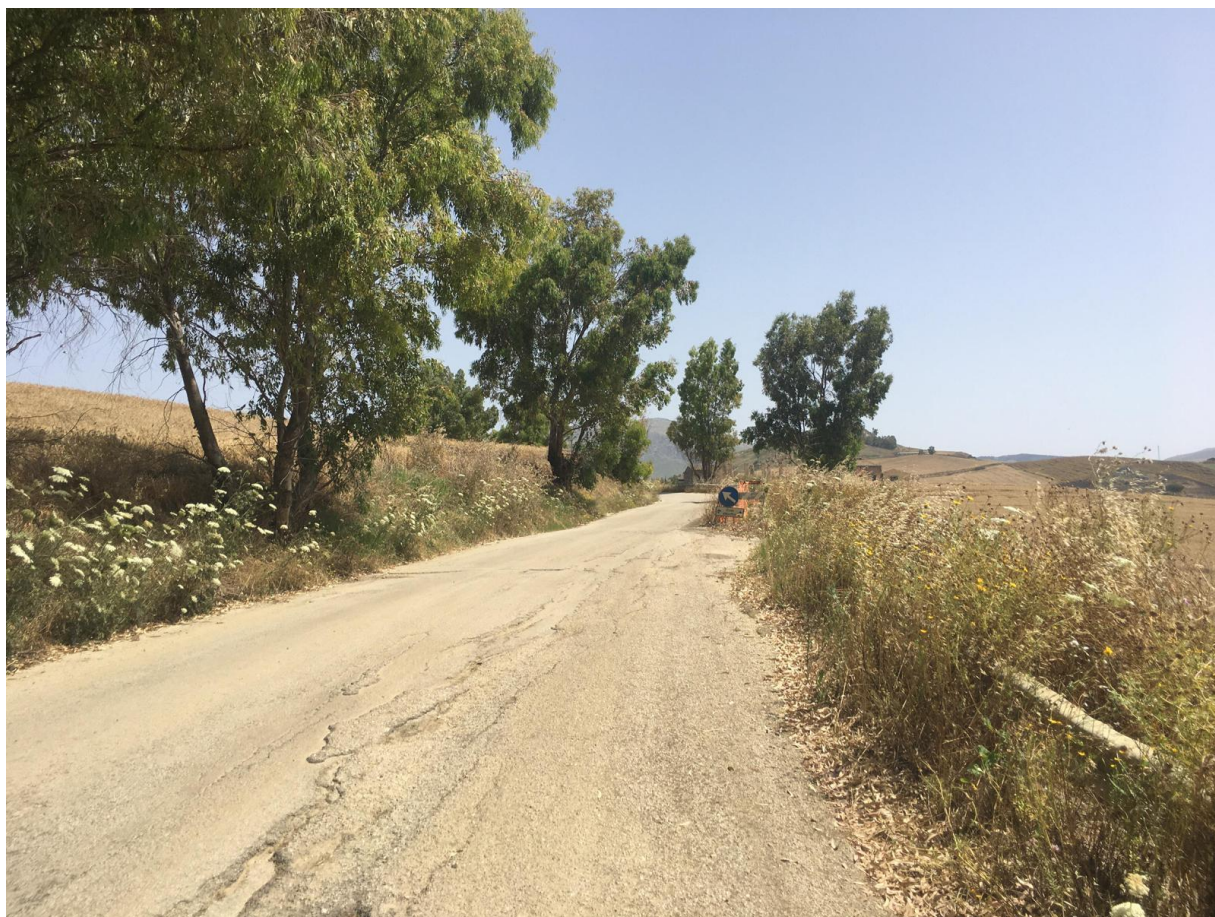
Foto 06 - Sede stradale oggetto di intervento
