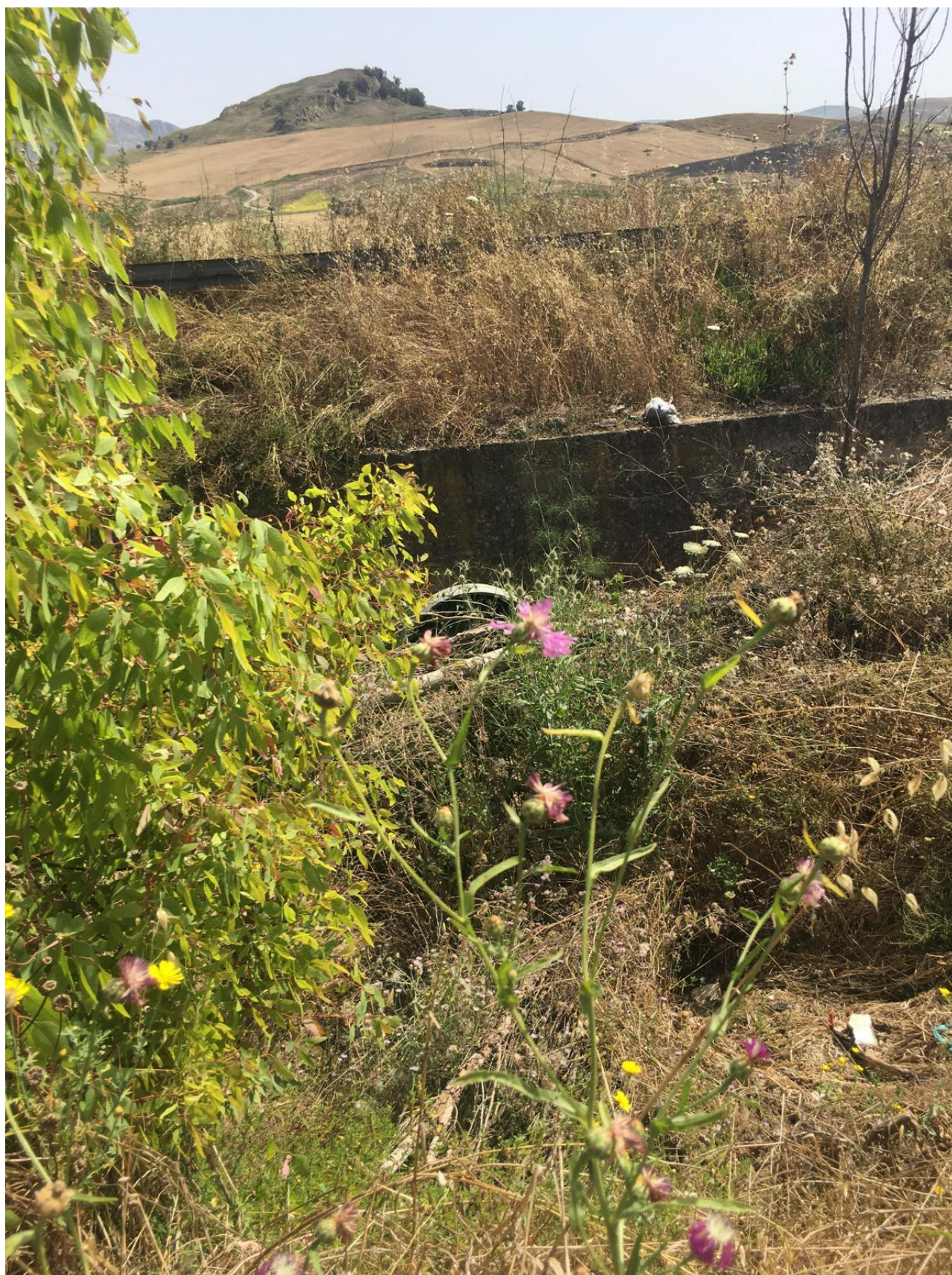
Foto 03 – Particolare: pozzetto da rifunionalizzare
