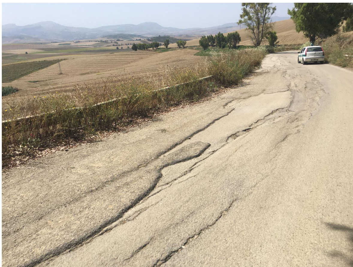
Foto 07 - Sede stradale oggetto di intervento
