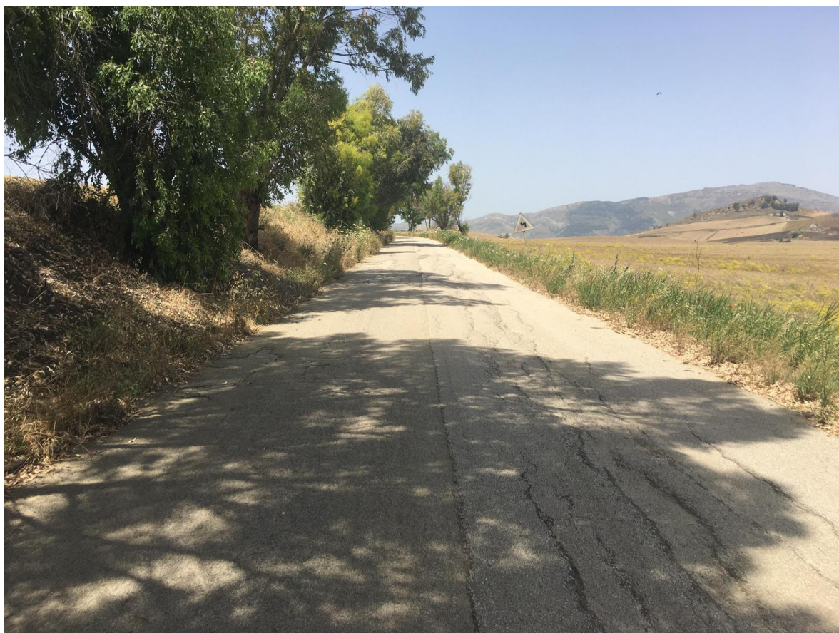
Foto 01 - Sede stradale oggetto di intervento
