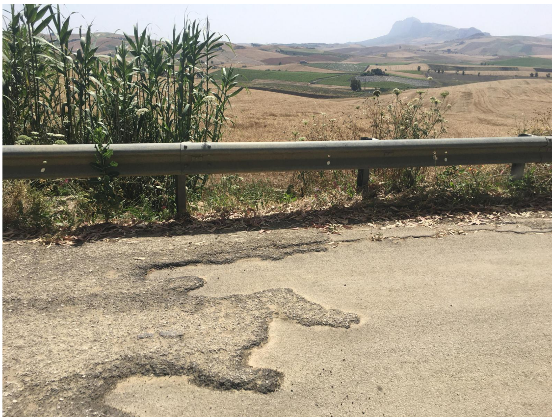
Foto 05 – Particolare: Barriere metalliche
