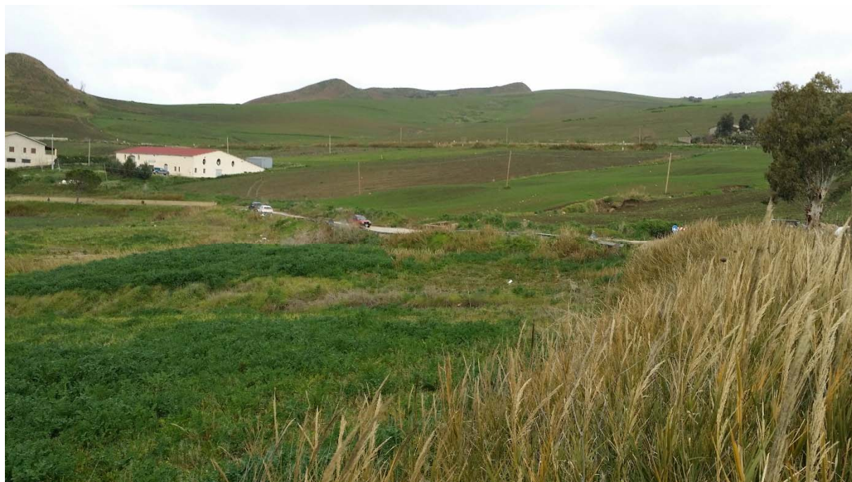
Fig. 78. Dissesto al km 22+700. Vista da valle (in direzione S. Cipirello) della strada dissestata. Gli spostamenti subiti dalla strada sono di metri.
