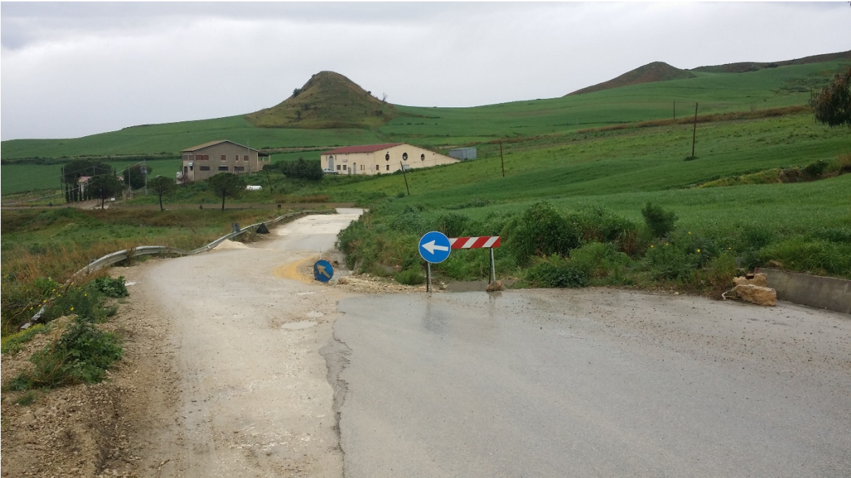
Dissesto al km 22+800. Vista (in direzione S. Cipirello) della strada dissestata. Gli spostamenti subiti dalla strada sono di parecchi metri.
