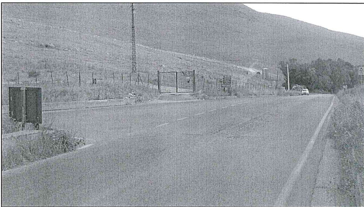
Foto n. 14 - Bivio Bellolampo, di innesto con la S.P. n. 3 bis di Torretta, alla progr.va km.ca 7+180 circa. (Zona S.I.C.- Sistemazione bivio)
