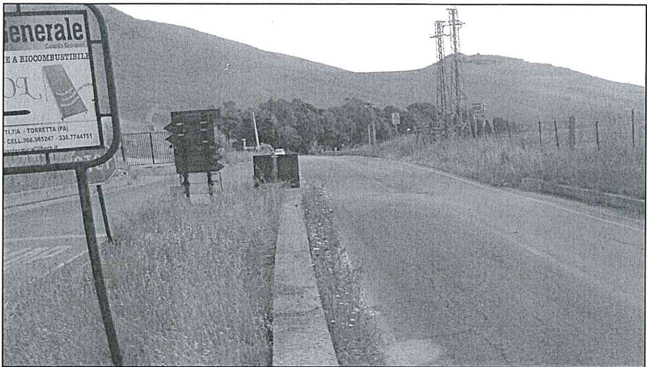
Foto n. 15 - - Bivio Bellolampo, di innesto con la S.P. n. 3 bis di Torretta, alla progr.va km.ca 7+180 circa. (Zona S.I.C.- Sistemazione bivio)
