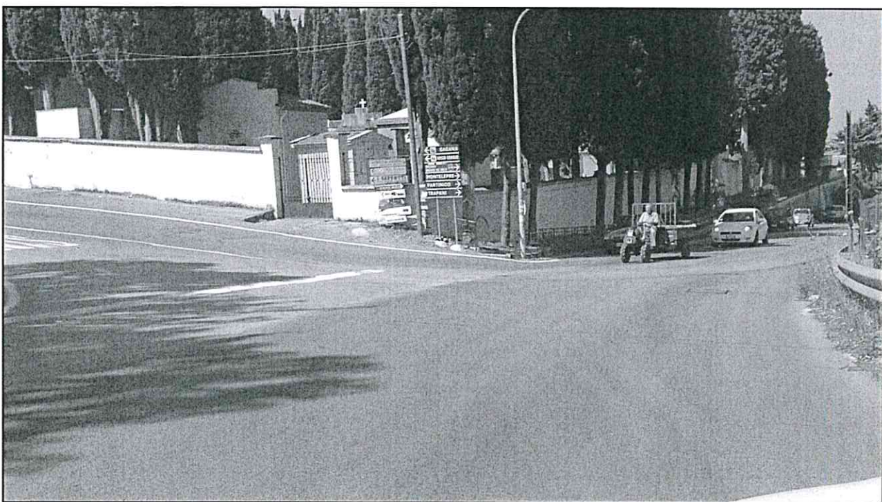
Foto n. 18 - Bivio Sagana, innesto con la Interc. N. 7, alla progr.va km.ca 15+215 c. (sistemazione bivio).
