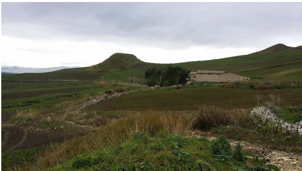
Fig. 79. Dissesto al km 22+700. Vista della zona a monte della strada in corrispondenza della pista ciclabile in corrispondenza della quale gli spostamenti sono superiori ai 10m.
