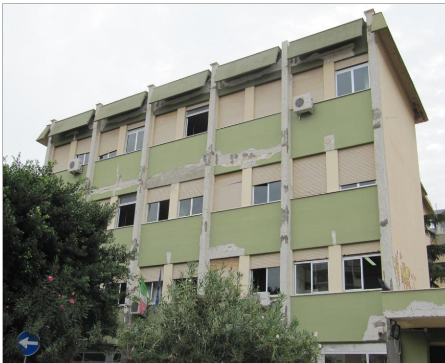
FOTO N. 1 – IL PROSPETTO PRINCIPALE CON LE PARTI DI INTONACO AMMALORATO
