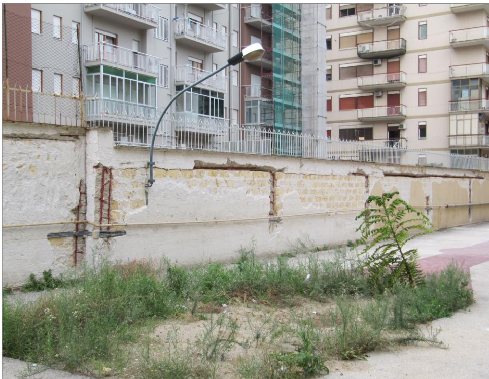
FOTO N. 5 – IL MURO DI RECINZIONE E LA PISTA PER IL SALTO IN LUNGO
