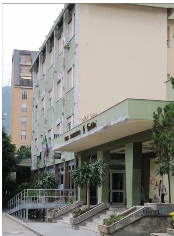
FOTO N. 1 – IL PROSPETTO PRINCIPALE CON LE PARTI DI INTONACO AMMALORATO
