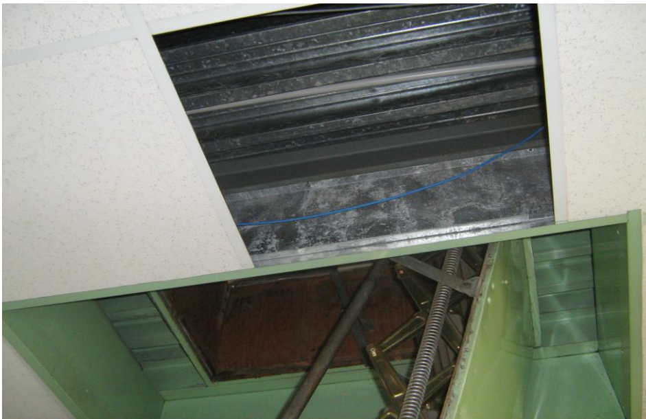
Foto n. 3 - La copertura da coibentare.
