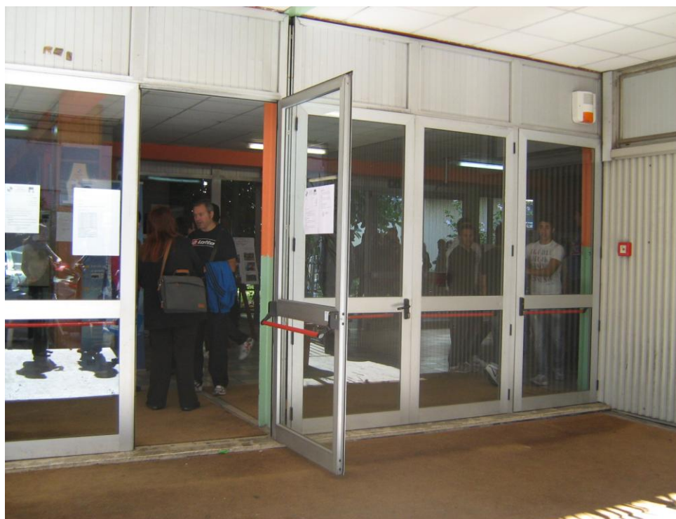
Foto n. 4 - L'ingresso alla scuola.
