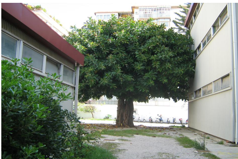
Foto n. 7 - Spazi esterni da ripristinare.
