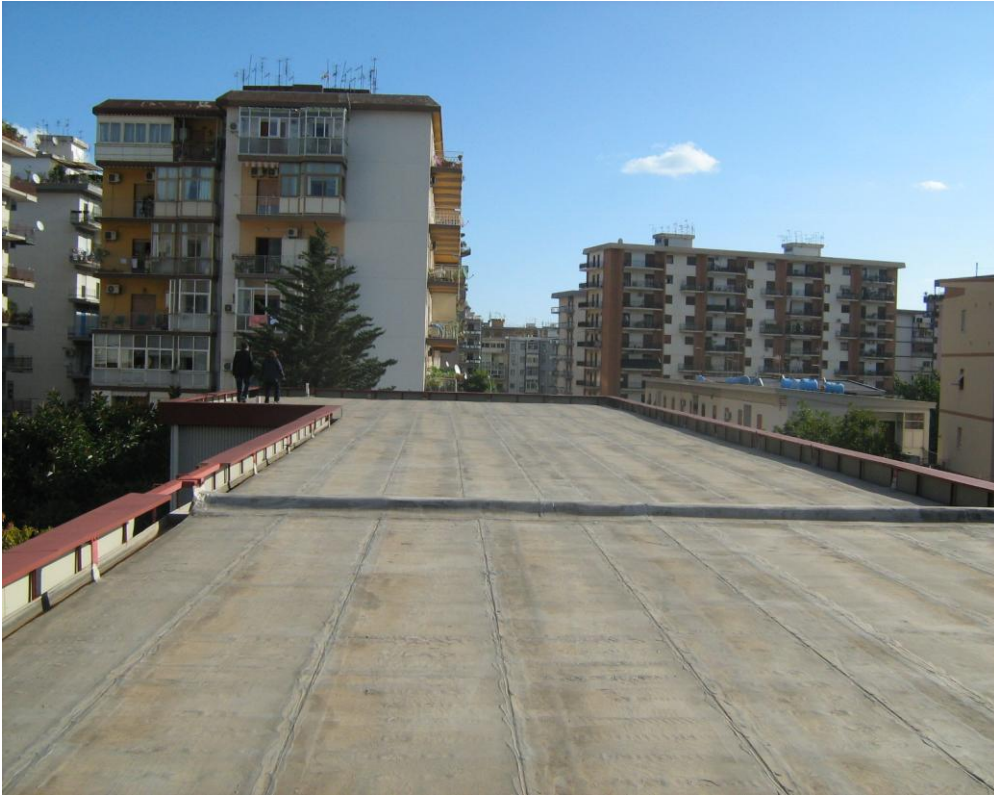
Foto n. 2 - La copertura a terrazzo da coibentare.
