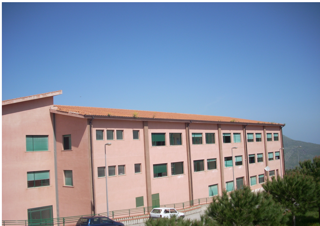
Foto 3 – Infissi Sede Via Majorana - Marineo
