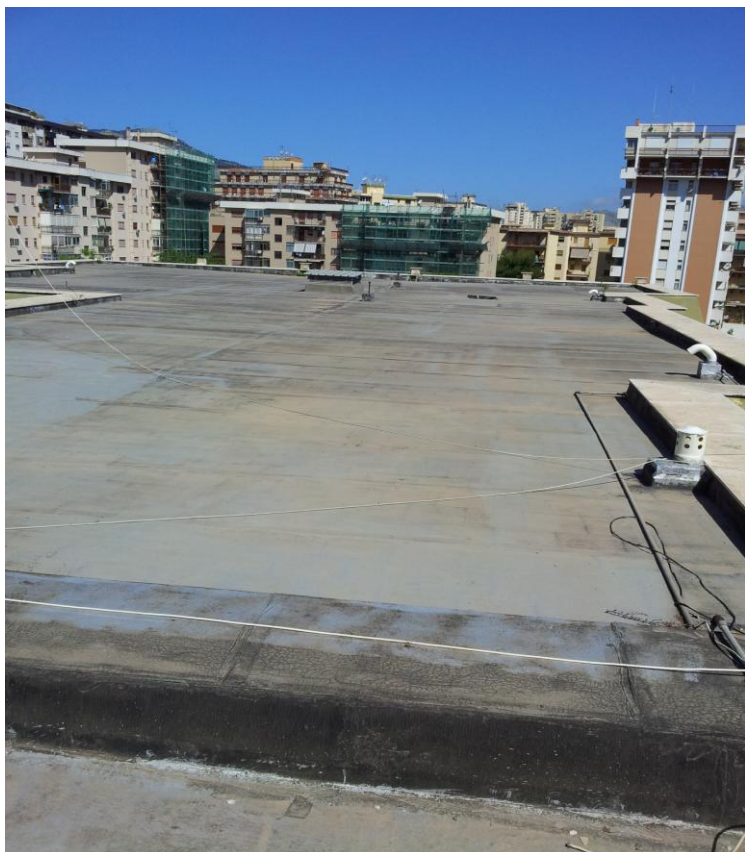
Foto 1 – Terrazzo di Copertura
