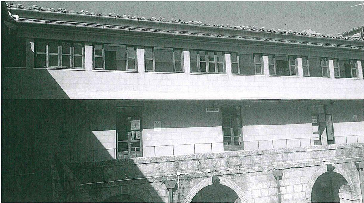
FOTO N° 6 – Il prospetto interno sulla corte (restauro infissi del 2° e 3° livello - sez. B-B)
