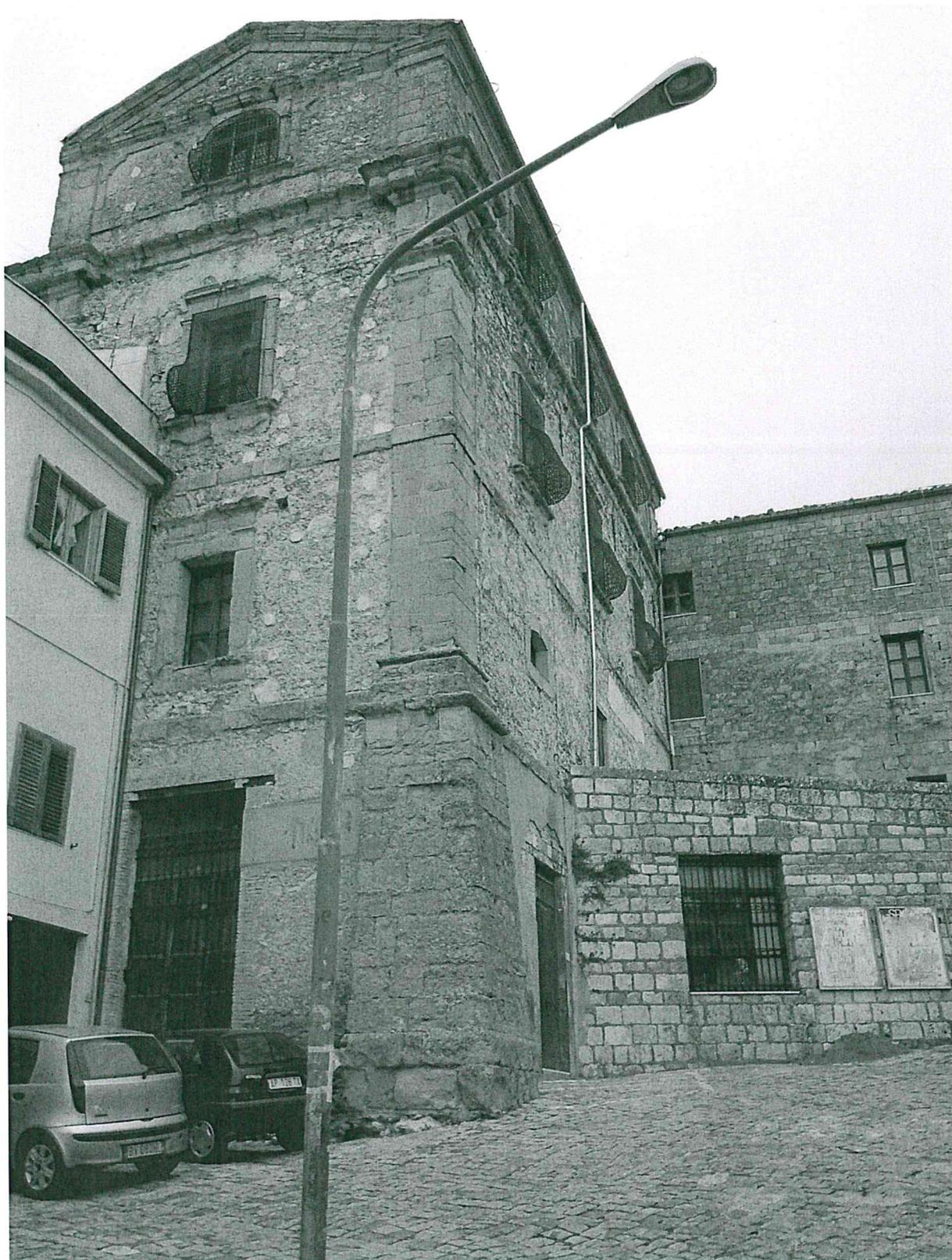
FOTO N° 2 – Il prospetto laterale su Piazza Domina (messa in sicurezza e restauro di cornici e parte di prospetto ammalorato)
