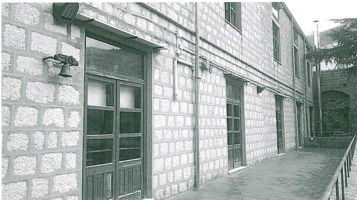
FOTO N° 4 – Il prospetto interno sulla corte (restauro infissi del 2° e 3° livello - sez. A-A )
