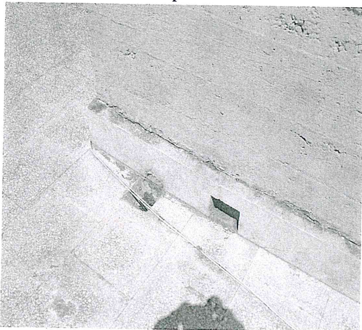
FOTO N. 16 Terrazza di copertura
