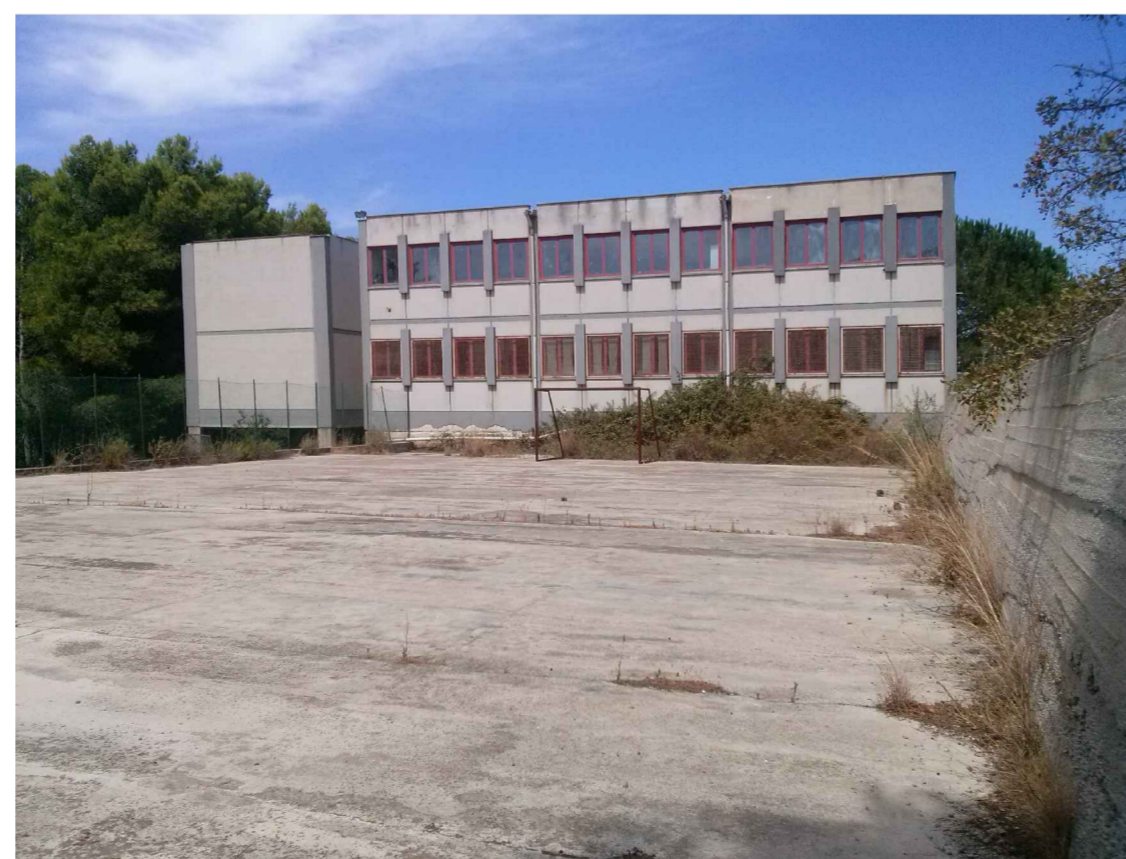
Rilievo fotografico del complesso scolastico
