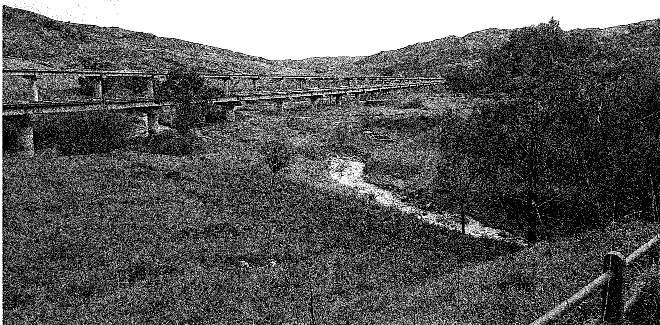
Foto n. 2 – Torrente Guardiola: tratto a valle del ponte
