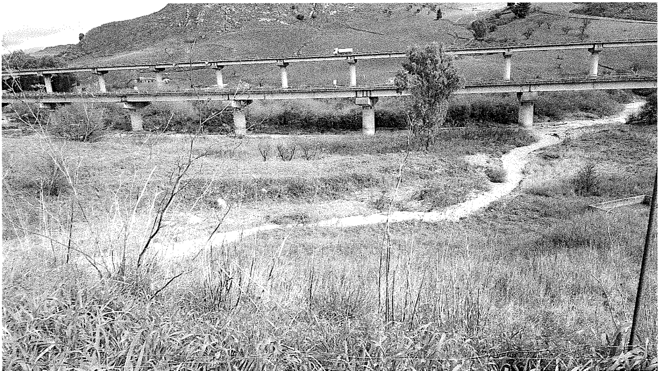
Foto n. 4 – Torrente Guardiola: tratto a valle del ponte
