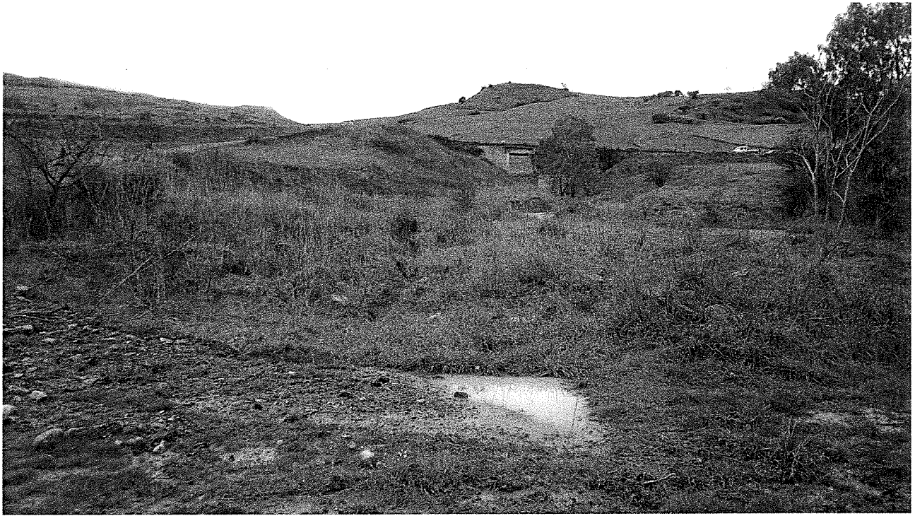
Foto n. 3 – Torrente Guardiola: tratto a valle del ponte
