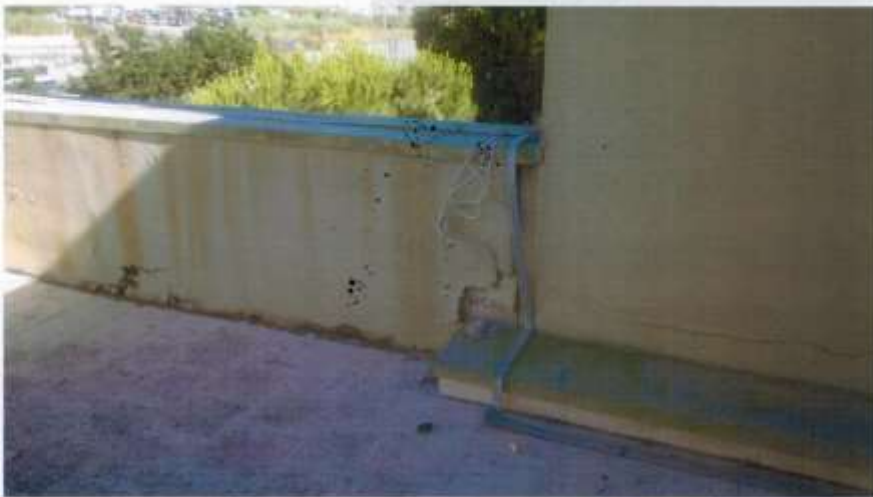
scorci di copertura sui quali si prevedono interventi per la impermeabilizzazione
