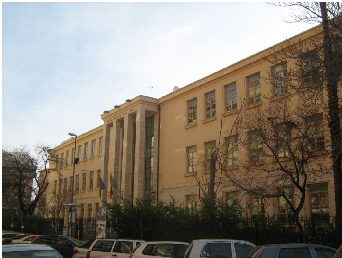
Foto n. 1- Il prospetto principale su via Canonico Rotolo.
