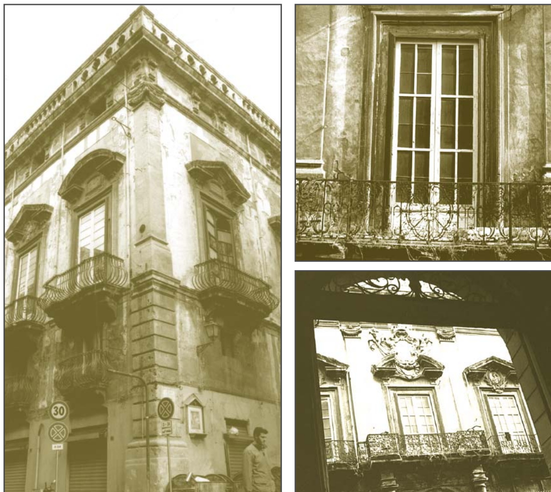
Alcuni particolari del Palazzo, prima del restauro
