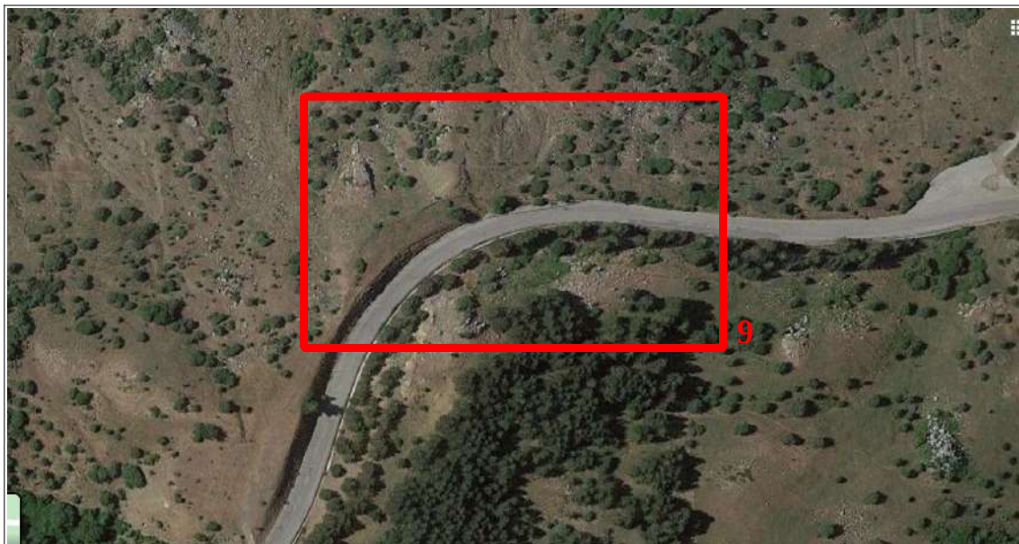
INTERVENTO N° 9: PROGRESSIVA KM 26+300
