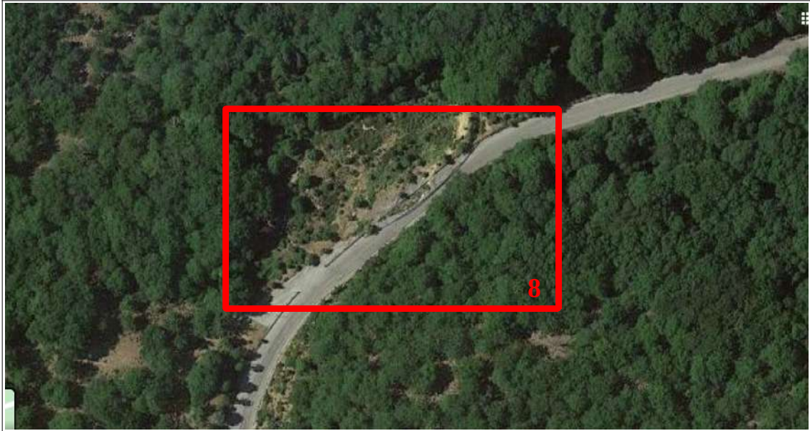
INTERVENTO N° 8: PROGRESSIVA KM 23+900
