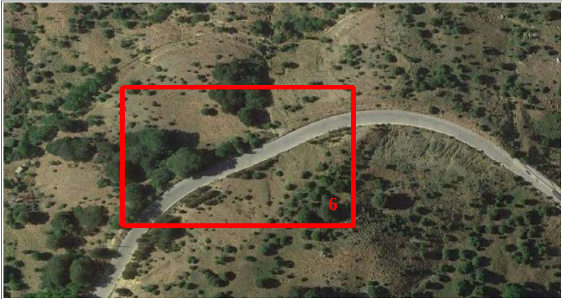
INTERVENTO N° 6: PROGRESSIVA KM 19+900
