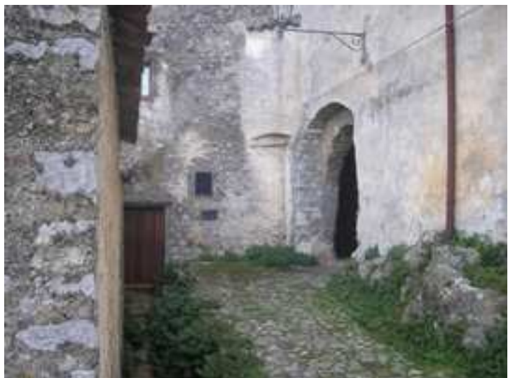
Interno della porta di accesso al Castello
