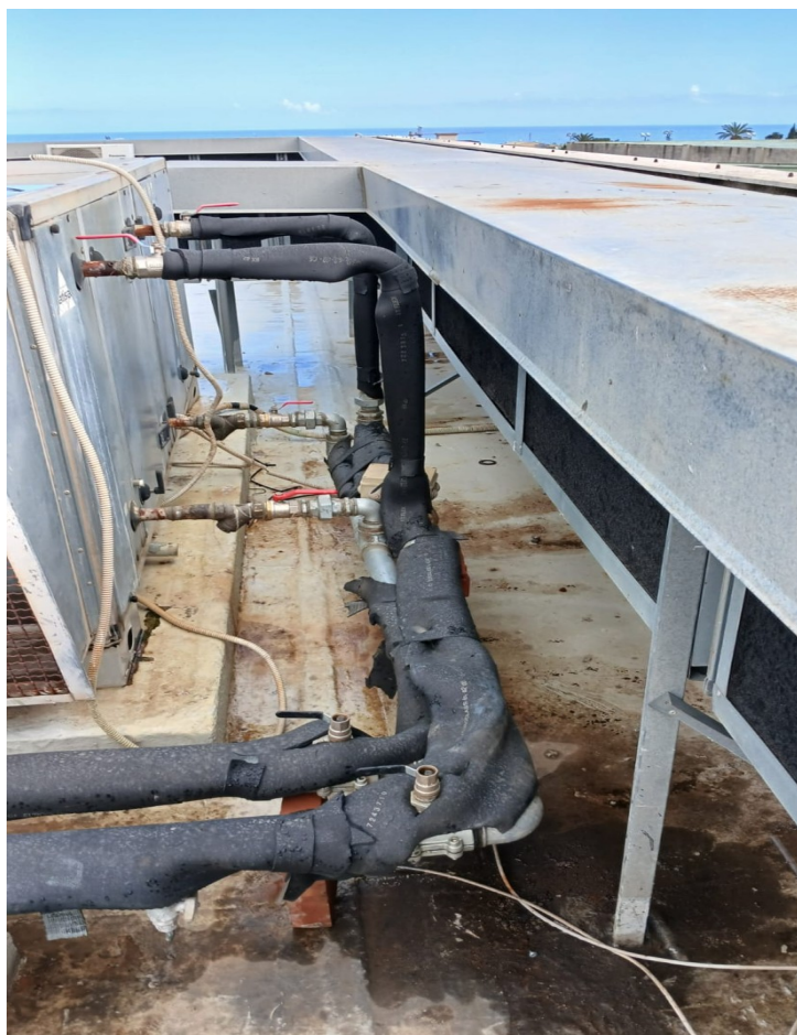
Collocazione di tubazioni in Mannesmann compreso valvole, raccorderia e guaina di isolamento.
