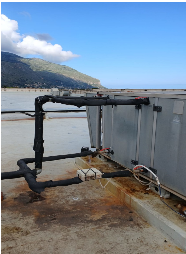
Collocazione di tubazioni in Mannesmann compreso valvole, raccorderia e guaina di isolamento.
